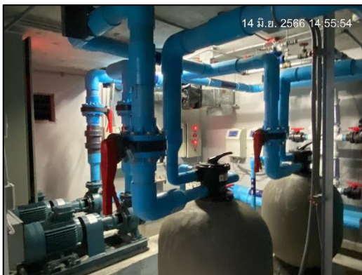
ภาพที่ 26 ระบบเกลือของสระว่ายน้ำ
