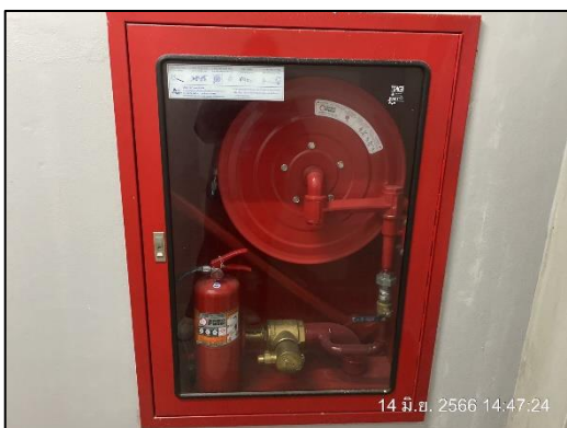
ภาพที่ 50 ตู้เก็บสายฉีดน้ำดับเพลิง
