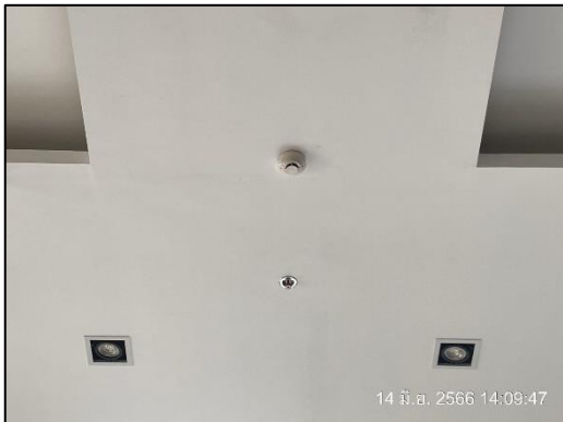
ภาพที่ 52 Smoke Detector และ Heat Detector
