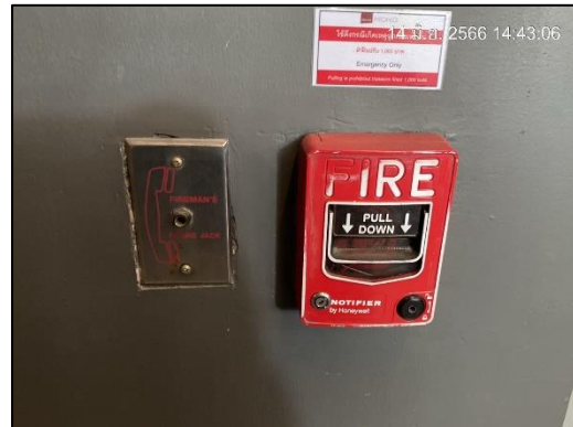
ภาพที่ 53 เครื่องแจ้งเหตุแบบใช้มือดึง
